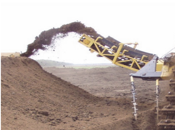
Рис. 5. Криволінійний конвеєр-евакуатор ґрунту
