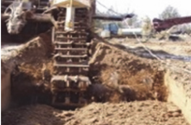
Рис. 4. Процес розробки ґрунту
