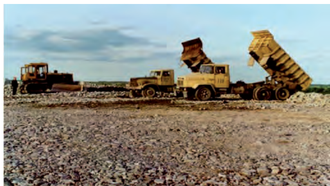
Рис. 2. Горнотехническая рекультивация на хвостохранилище КБЖ, г. Желтые Воды (фото)
