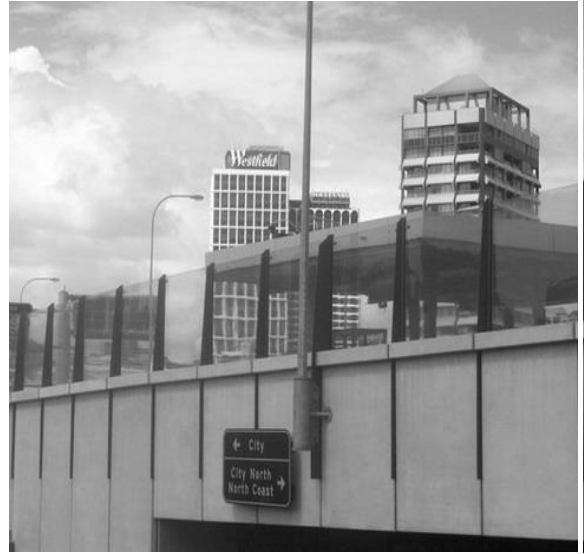
Рис. 1. Конструкції шумозахисних екранів.
