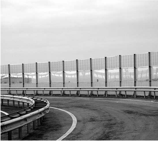
Рис. 1. Конструкції шумозахисних екранів.
