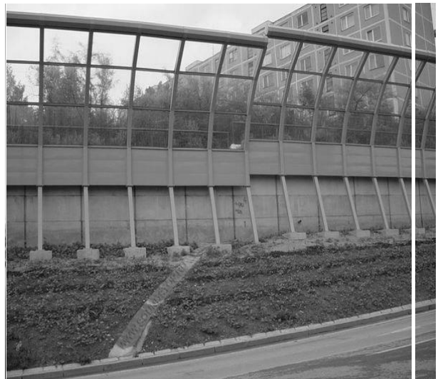
Рис. 1. Конструкції шумозахисних екранів.
