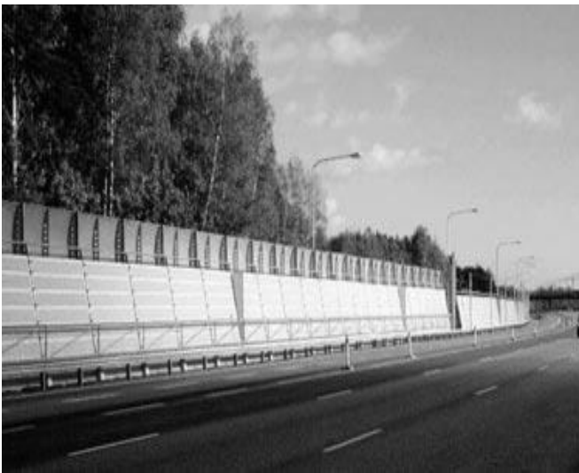
Рис. 1. Конструкції шумозахисних екранів.
