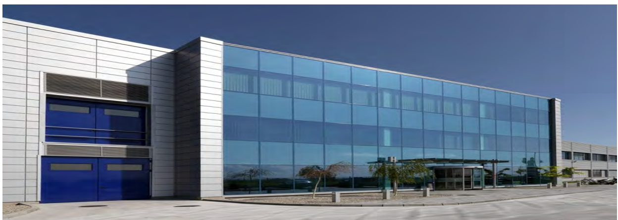
Рис. 5. Приклад використання самоочисного скла Pilkington Aktiv
