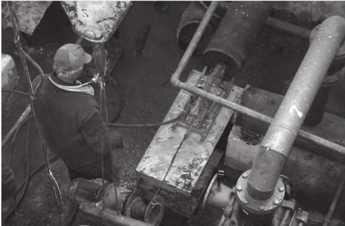
Рис. 1. Виконання процесу ізоляції напірних трубопроводів
