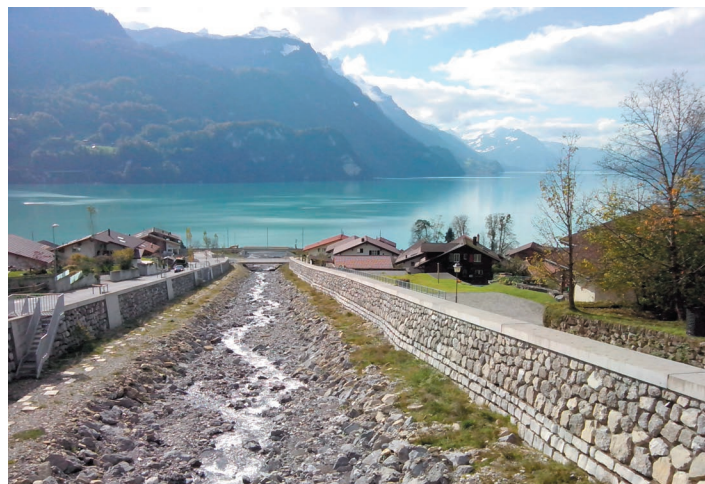
Фото 3б. Сучасні захисні стінки вздовж русла річки, яким у 2005 р. рухалась гірська маса зсуву. Будівлі обабіч повністю відбудовані навізамін зруйнованих (див. фото 3а для порівняння)
