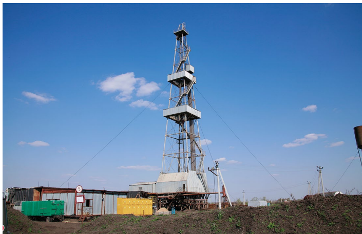
Фото 1. Бурова установка “Уралмаш 3Д”
