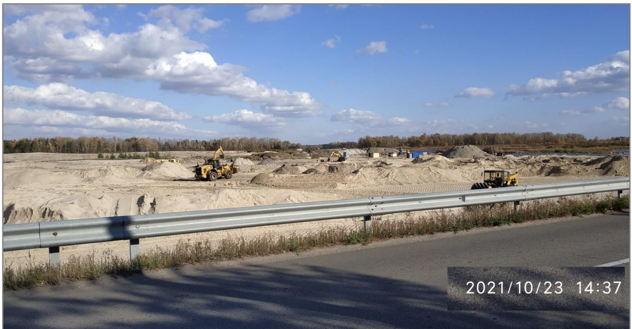
Рис. 4. Активне відновлення намивання земель і забудова бувшої акваторії
