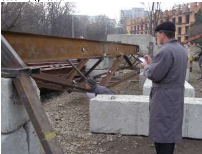
Рис. 6. Монтаж дослідного обладнання на СНКК спеціалістами НДЛ-19.
