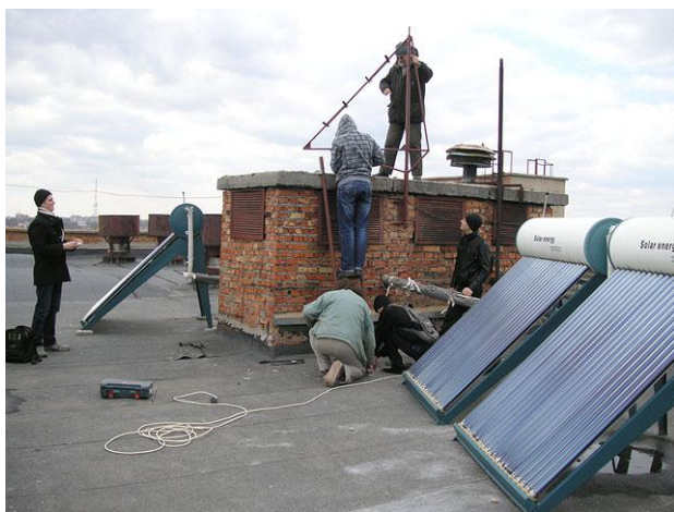
Рис. 1. Монтаж каркаса панелей солнечных батарей на крыше университета.
