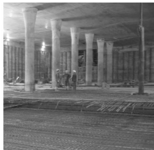
Рис. 3. Строительство подземного паркинга под Гёте Платц во Франкфурте-на-Майне Конструктивные особенности при строительстве методом «сверху вниз»
