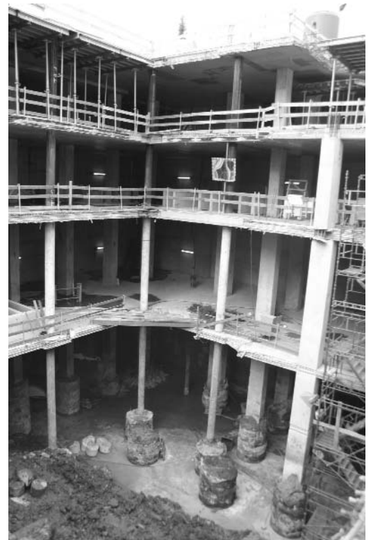
Рис. 5. Устройство временных и постоянных буровых колонн
