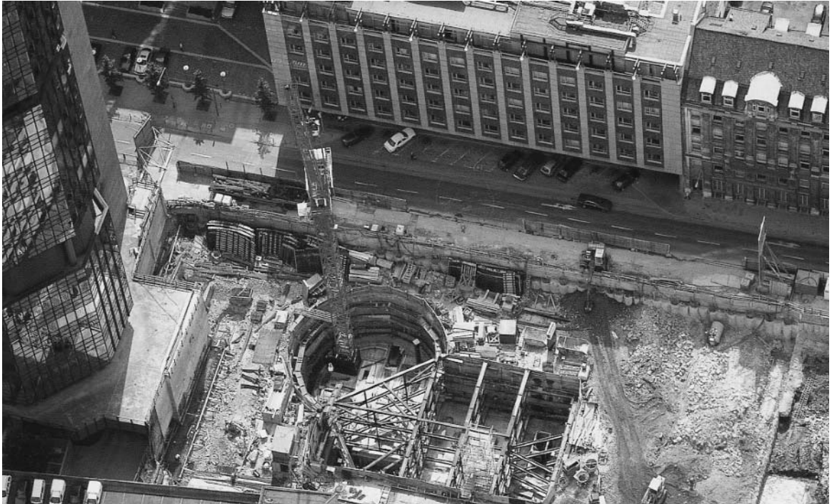
Рис. 2. Пионерный котлован с распорками при строительстве высотного здания MainTower во Франкфурте-на-Майне (вид сверху)
