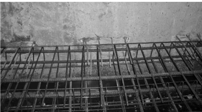
Рис. 4. Узлы соединения перекрытия и ограждения котлована
