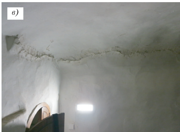
Рис. 2. Деформування несучих елементів Церкви Різдва Христова:
