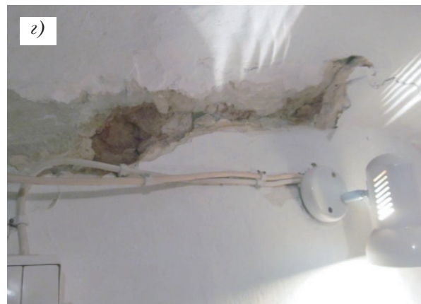
Рис. 2. Деформування несучих елементів Церкви Різдва Христова:
