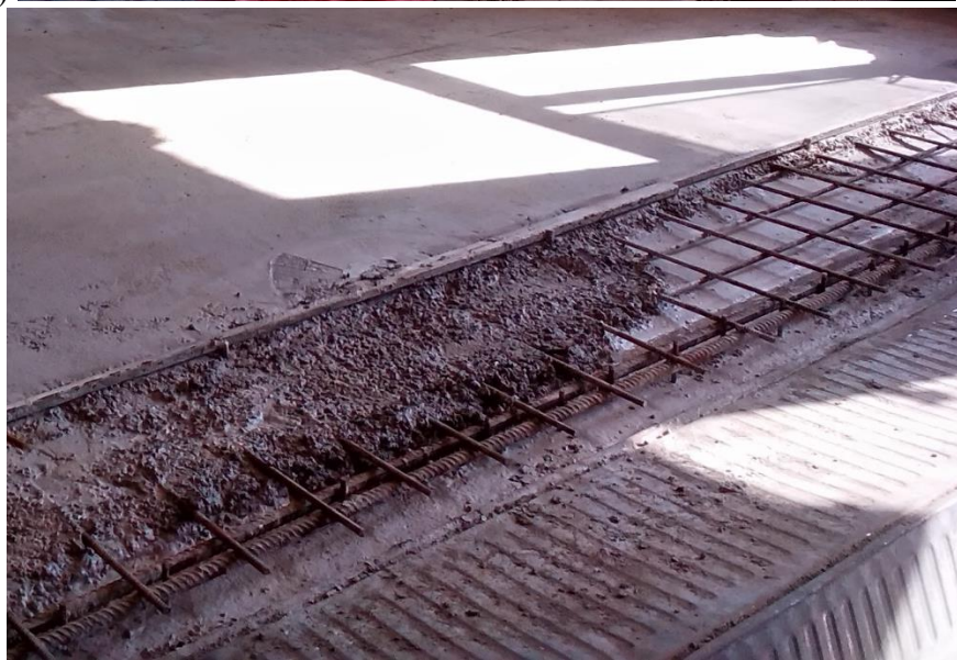
Рис.3 – Влаштування монолітної залізобетонної плити в незнімній опалубці а- Укладка опалубки та армування; б – бетонування плити перекриття
