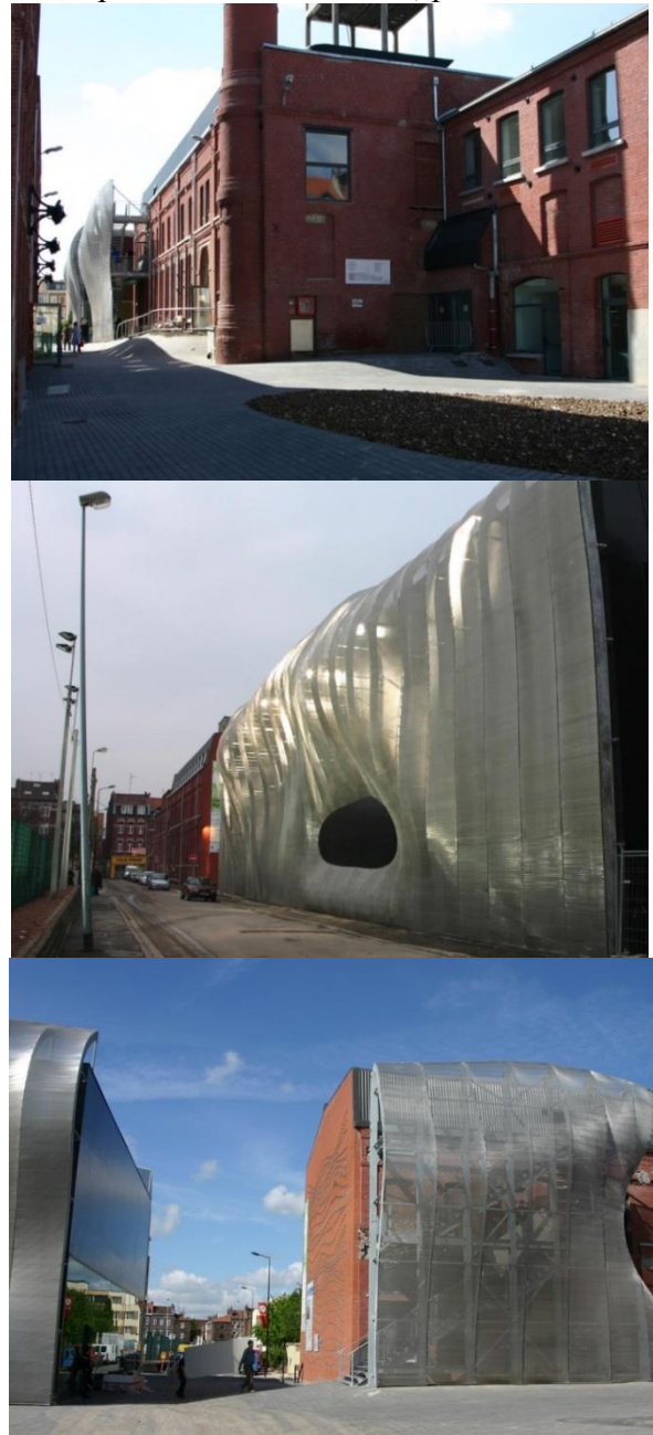
Рис.2. Вигляд будівлі текстильної фабрики в місті Ліль (Франція) після ревіталізації під культурний центр
