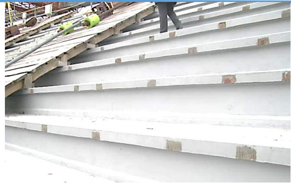
Рис.2. Вигляд панелей-складок після виконання ремонтно-відновлювальних робіт
