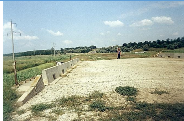
Рис. 4. Мост через речку Ташбунар на автомобильной дороге «Подъезд к г. Измаил»
