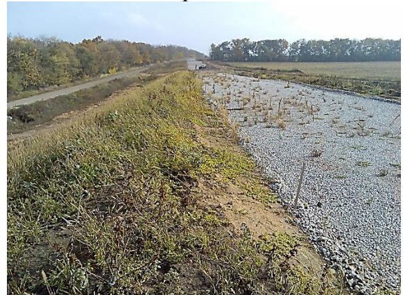
Рис. 2. Земляное полотно и придорожная полоса на участке автодороги «Подъезд к г. Измаил»
