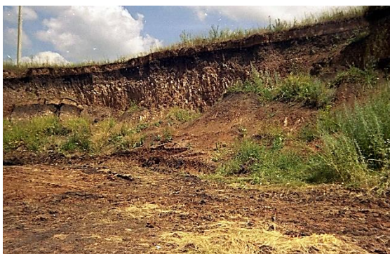
Рис. 1. Оползень на дороге «Красные Окны – Новосамарка»
