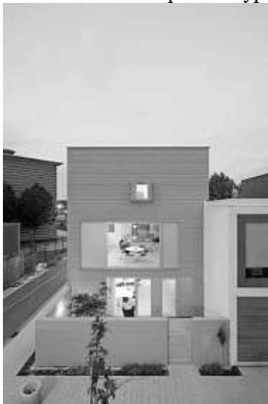
Рис. 5. Главный фасад дома
