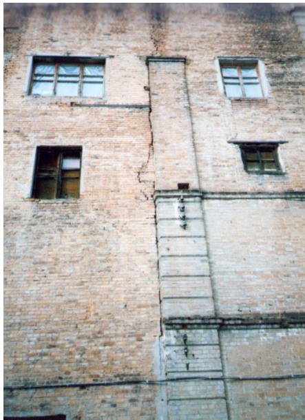
Рис. 2. Вертикальные трещины
