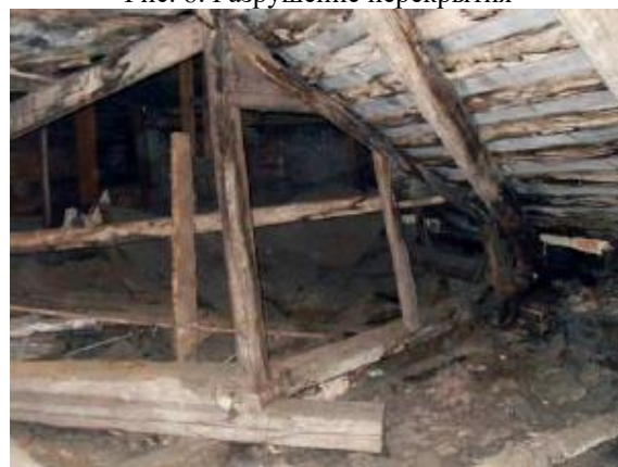
Рис. 9. Загнивание покрытия
