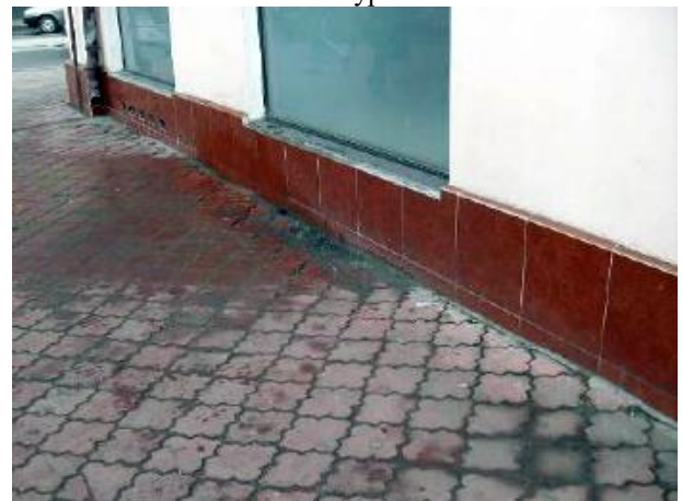
Рис. 5. Нарушение отмостки
