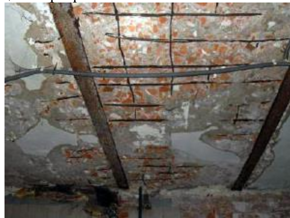
Рис. 8. Разрушение перекрытия
