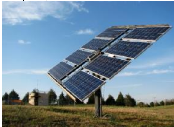
Рис. 5. Приклад панелі з системою стеження (повороту) за Сонцем.
