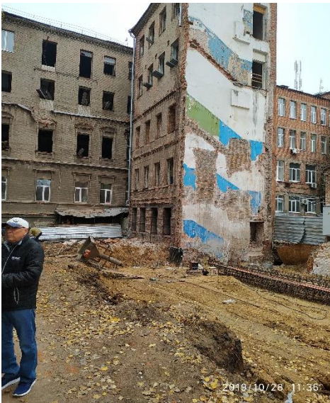
Рис. 4. Подготовленный котлован под пристраиваемое здание
