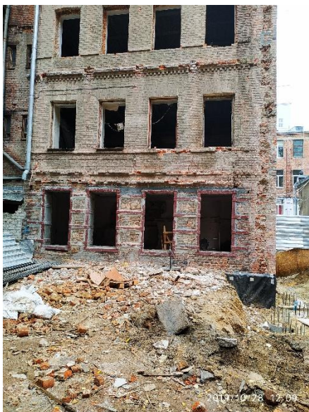
Рис. 3. Усиление простенков на фасаде со двора
