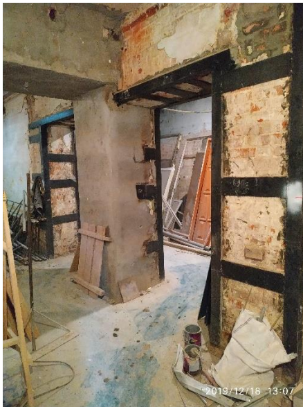
Рис. 1. Усиление кирпичных столбов
