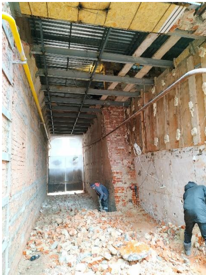
Рис. 2. Расширение проема арки
