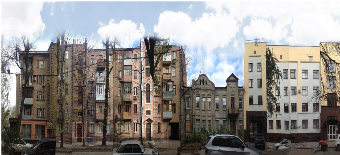
Рис. 1. Загальний вигляд будівлі по вулиці Костомарівській, 13
