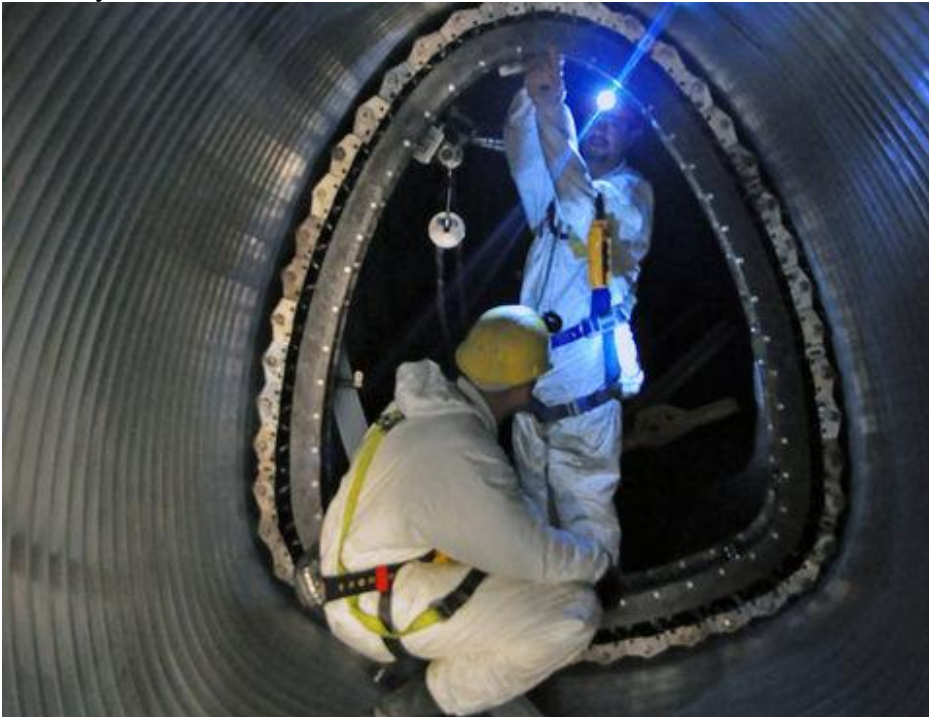
Рис. 3. Відновлення трубопроводу напівеліптичної (шатрової) форми методом спіральної навивки
