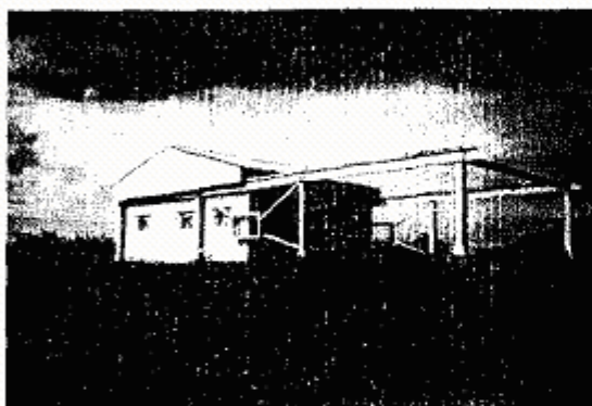
Рис.9. Павільйон під телескоп ТПЛ-1М в пункті Деренівка.
