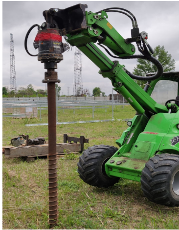
Рис. 2. Процес влаштування багатовиткової палі.
