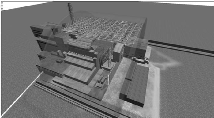
Рис. 4. Имитационная модель объекта "Укрытие" и НБК.
