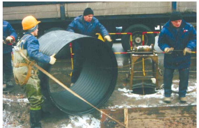
Рис. 4. Подача трубы во временную шахту
