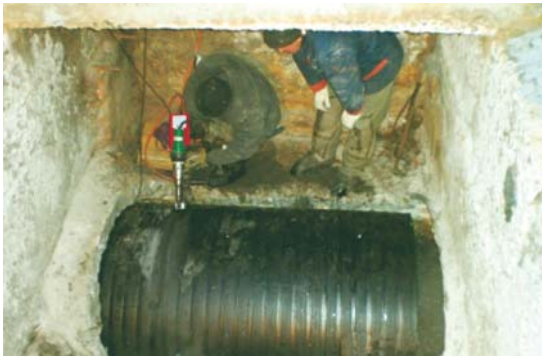
Рис. 6. Сварка коротких труб
