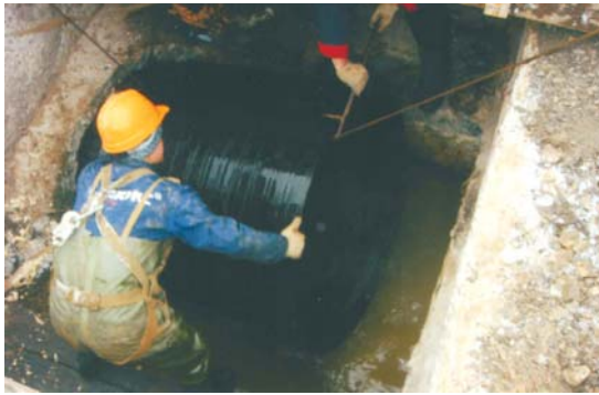
Рис. 5. Введение трубы в разрушенный трубопровод
