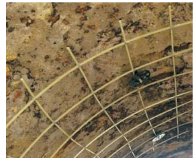
Рис. 24. Армирование стеклопластиковой арматурой сводовой части коллектора
