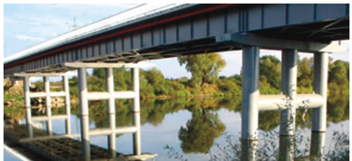
Рис. 2. Фасад сталезалізобетонного моста на км 9+442 автомобільної дороги Т-09-10 Бурштин-Калуш
