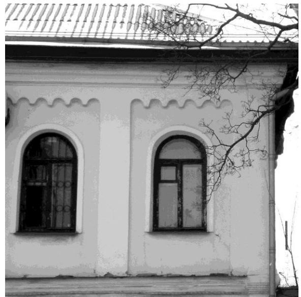
Рис. 5. Фрагмент фасаду будівлі. Формування полів толерантності
