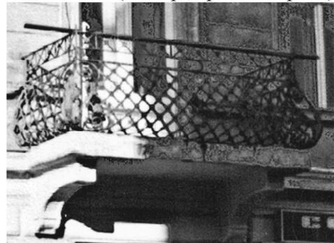
Рис. 20. Огорожа балкону житлового будинку на вул. Вітовського, 6 (друга половина XIX ст.)
