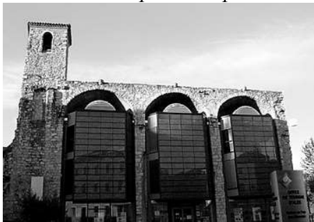
Рис. 3. Будівля церкви Groenhof Castel. Фландрія, Бельгія, 1830 р. Реконструкція арх. бюро «Samyn&Partners», 1996-99 рр.
