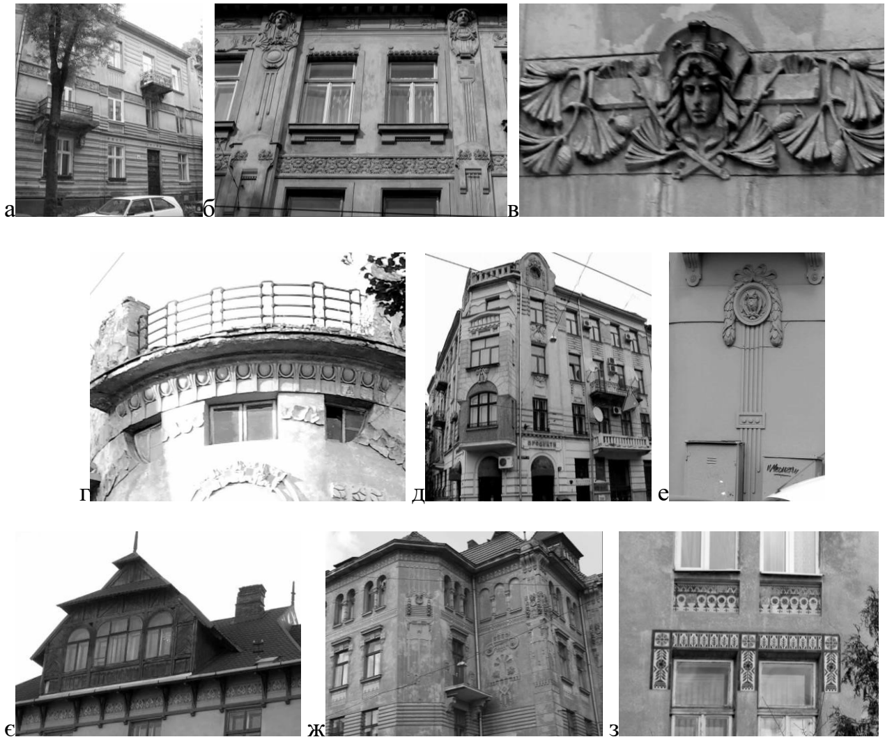
Рис. 5. Прийоми композиційні та прийоми стилізації архітектурного декору на основі природних, класичних, народних мотивів: а) вул. Донцова, 14 (рустування та міжповерховий карниз з мотивами китиці сосни); б) вул. Ген. Чупринки, 28 (міжповерховий карниз з мотивами ромашки); в) вул. Ген. Чупринки, 8 (маскарон оздоблений китицями сосни); г) вул. Акад. Богомольця, 3 (класичні мотиви іоніки); д) вул. С. Бандери, 6 (класичні мотиви, картуш, гірлянди); е) вул. І. Франка, 66 (класичні мотиви гірлянди); є), ж), з) народні мотиви (вул. Коцюбинського, 21; вул. Руська, 2; вул. Озаркевича, 2а).
