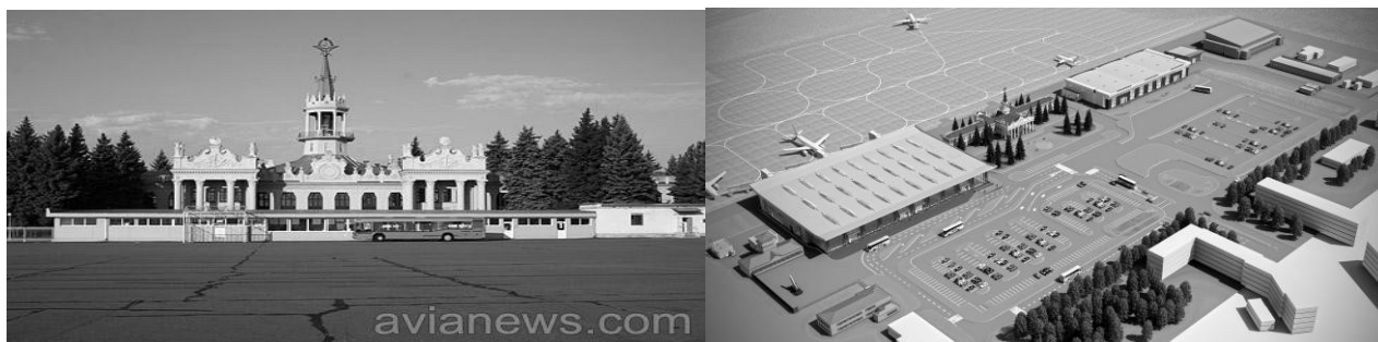
Рис. 2. Аеропорт «Харків» до реконструкції та після
