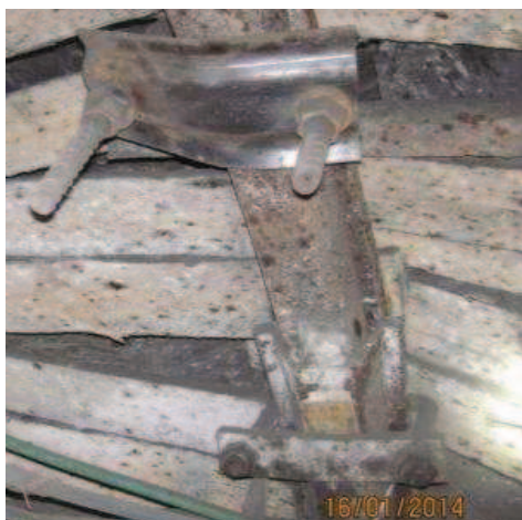
Рисунок 2 – Усиление крепи спаренными анкерами
