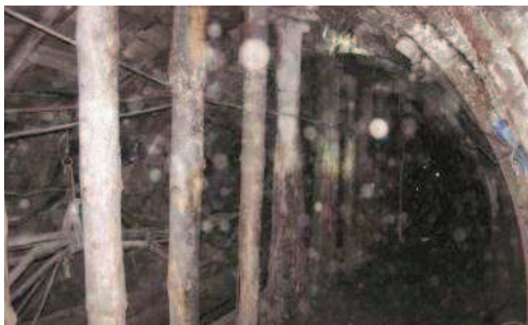
Рисунок 3 – Состояние конвейерного ходка после подрывки пород почвы до подхода лавы
