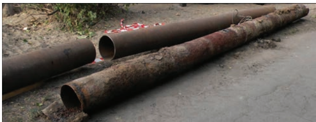
Рис. 10. Демонтированный участок трубопровода
