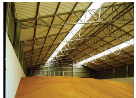
Рис. 9 – Зерносховище – сталеві будівля LLENTAB
