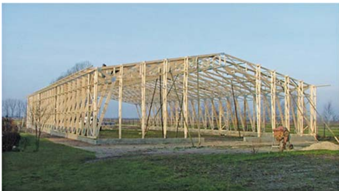
Рис. 43 – Каркас будівлі з дерев'яних конструкцій фірми «Прагма»
