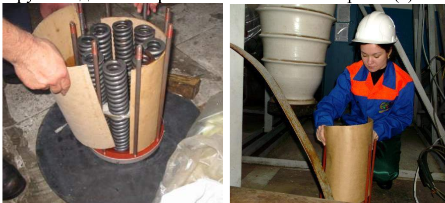
Рис. 6. Ізоляція пружин від корпусу головки вводу
