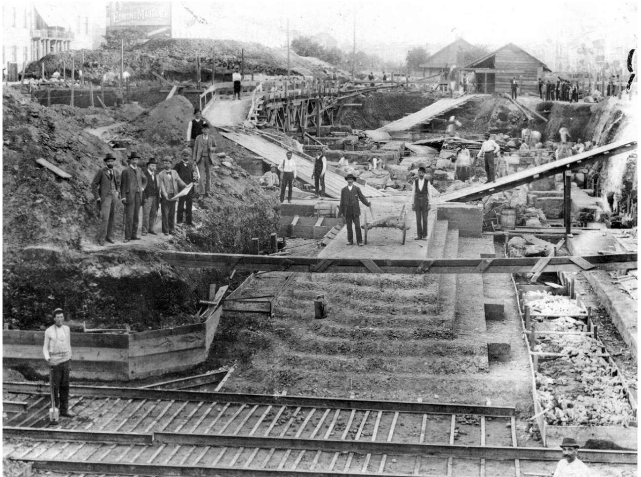
Рис. 1. Роботи з укладання фундаментів майбутнього оперного театру
