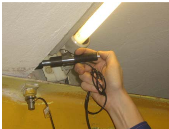
Рис. 2. Процедура создания вибропортрета элементов металлоконструкций.
