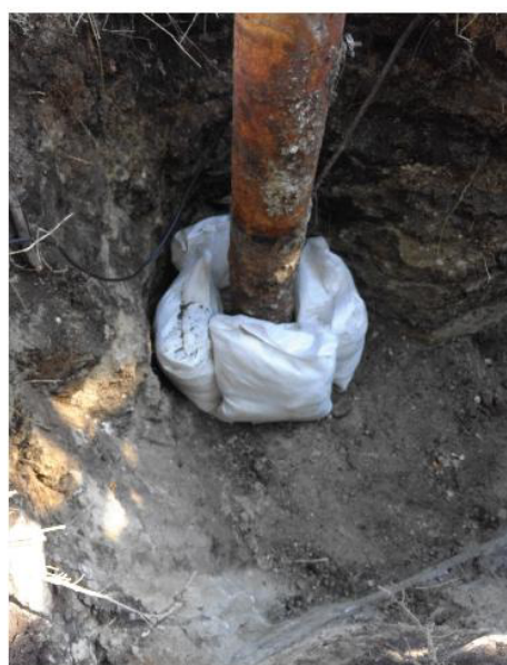
Рис. 2. Закладка мішків з хімічно-активними речовинами біля анодів
