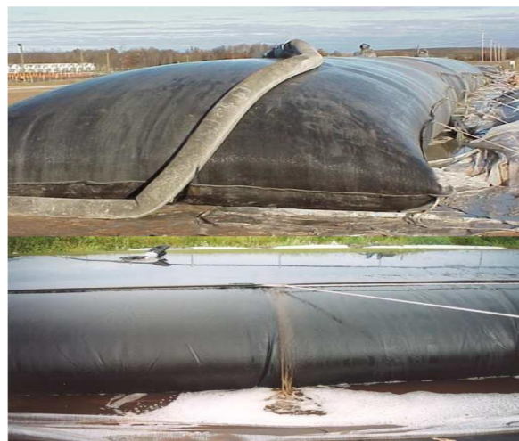
Рисунок 3 – Етапи «наповнення-зневоднення» за технологією геотекстильних контейнерів
