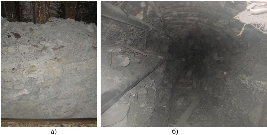
Рис.6. Перерізи порід підшови при веденні підрибок а) вентиляційний штрек 26 східної лави пл. m_3 ш. Трудівська (2013 р); б) 8 західний вентиляційний штрек пл. m_3 ш. ім. Є.Т. Абакумова (2014 р)
