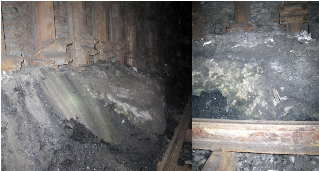
Рис.3. Загальний вигляд порід підшови після підривки і перемонтажу рейкового шляху
