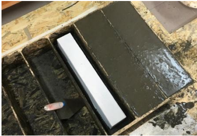
Рис. 3. Укладання шлакобетону
