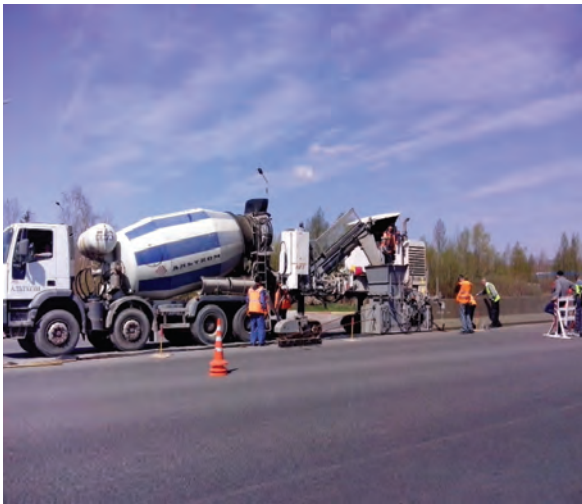
Рисунок 1 – Влаштування парпетного огороження типу «Нью-Джерсі»
