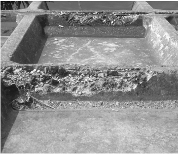
Рис. 2. Характерні пошкодження плит
