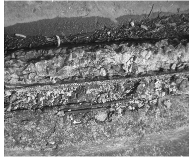
Рис. 2. Характерні пошкодження плит
