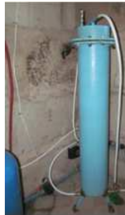
Рис. 5. Напірний пінополістирольний фільтр
