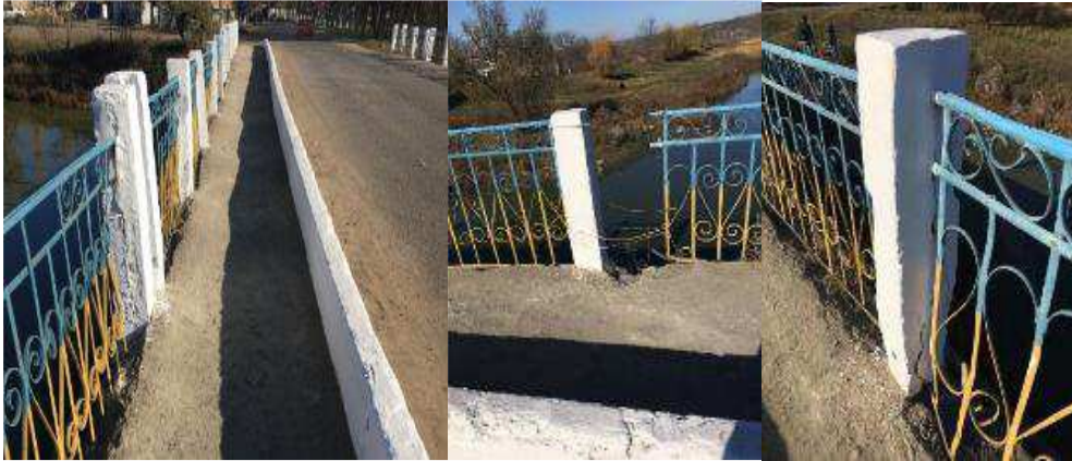
Рис. 4. Поява хвилястості на асфальтовому покритті. Відхилення опор огородження від вертикалі. Механічні пошкодження ґратчастого огородження
