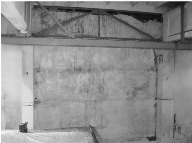
Рис. 1. Утворення грибкової цвілі на зовнішній стіні зали фільтрів
