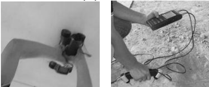
Рис. 2. Інструментальне обстеження монолітного безбалкового перекриття консервного цеху
