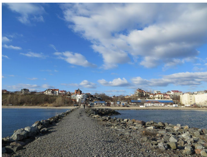
Рис. 2. Буна из каменной наброски в Крыжановке
